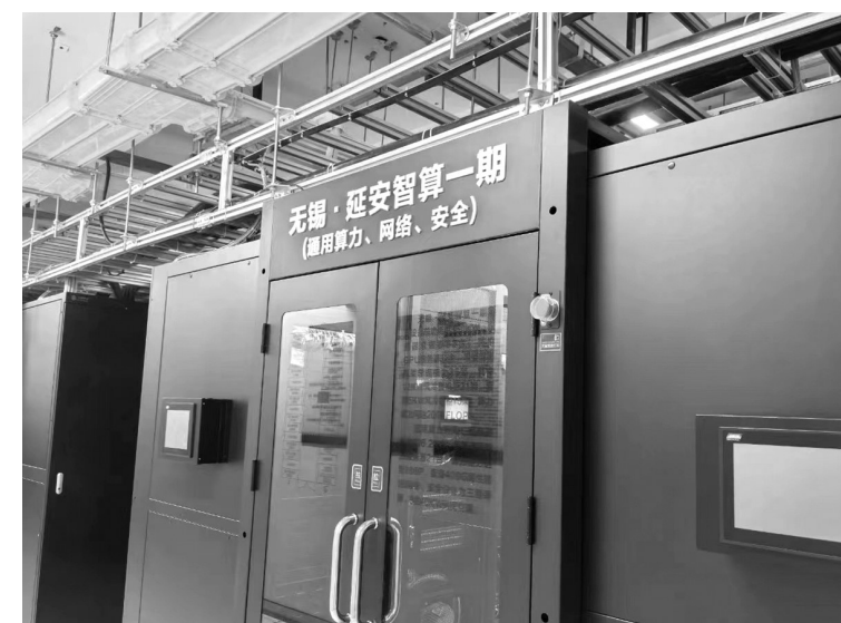
无锡·延安智算一期项目正在进行设备调试
