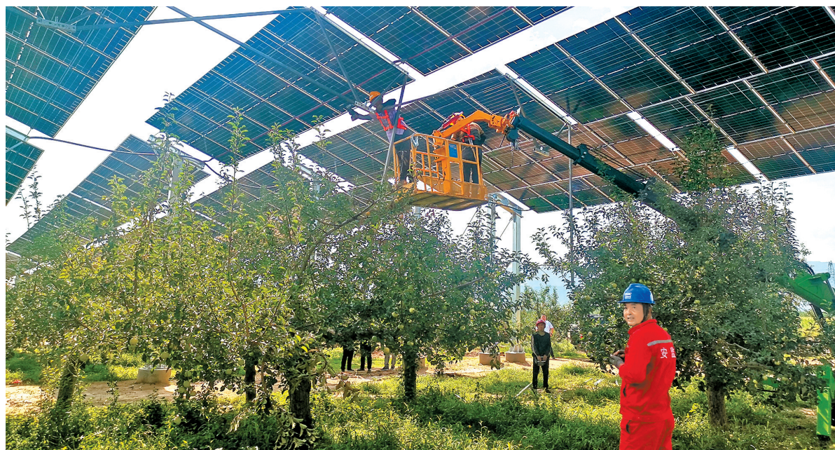
● 工人在安装光伏板
