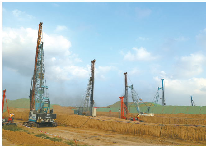
● 洛川苹果产业关联集中区施工现场
