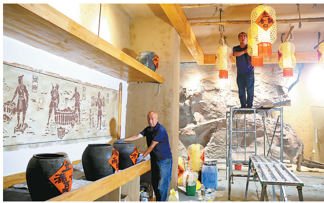
● 工人正在装修
