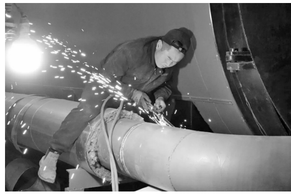
● 工作人员对管网进行检修
