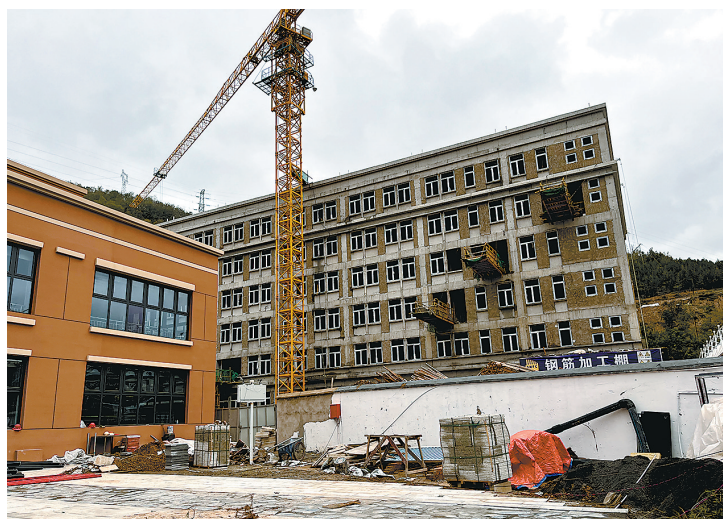
● 志丹县龙岗实验中学公寓楼项目建设现场
