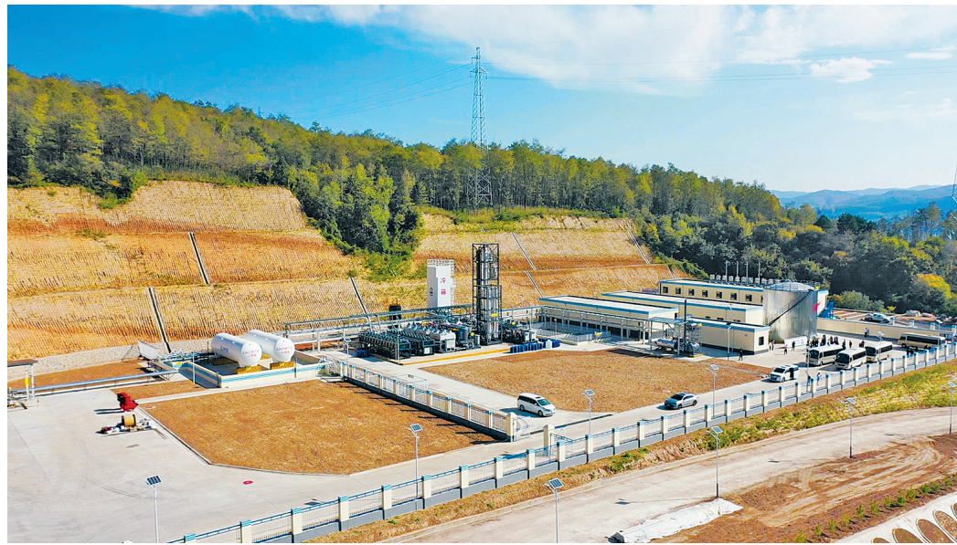
● 富县气化乡镇直罗民用调峰站项目厂区
