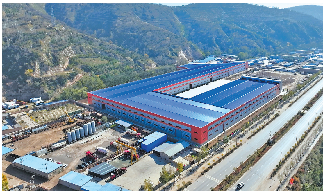
● 吴起县汽车改装及油气钻采设备制造项目主体厂房建设已完工
