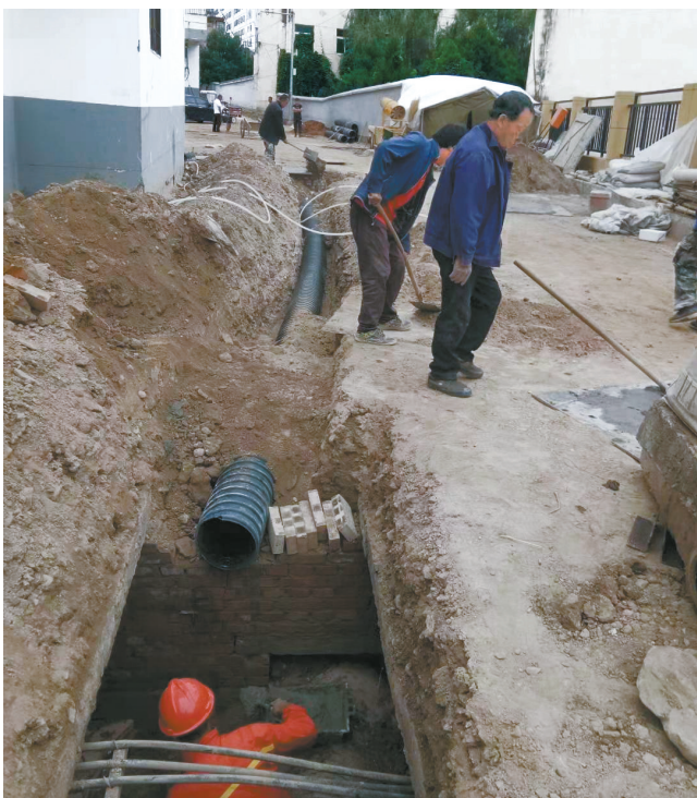
工人维修下水道
