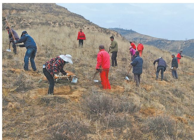
● 工人在挖树坑
