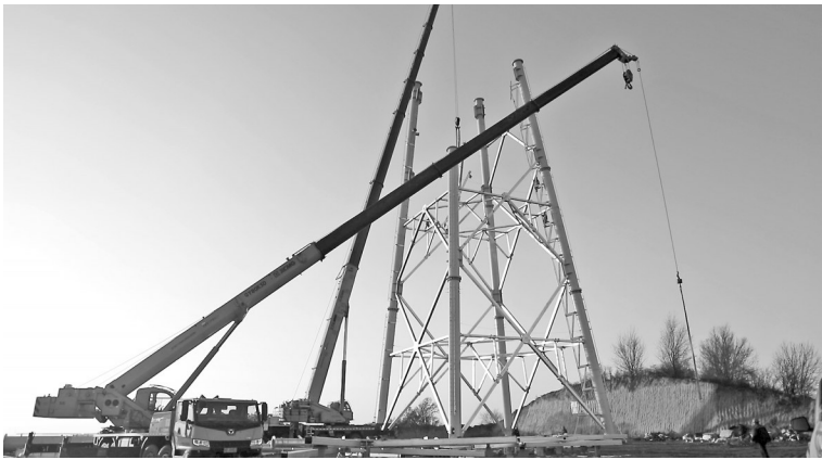
● 山地风电项目建设现场
