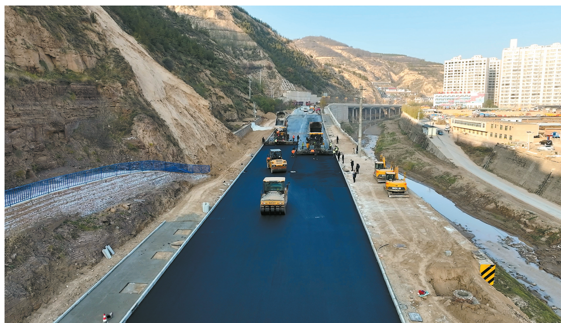
● 吴起县城北大道改造现场
