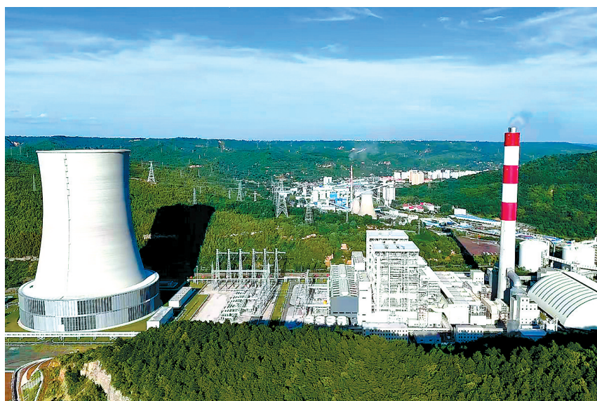
● 陕西黄陵发电有限公司2×660MW电厂全景
