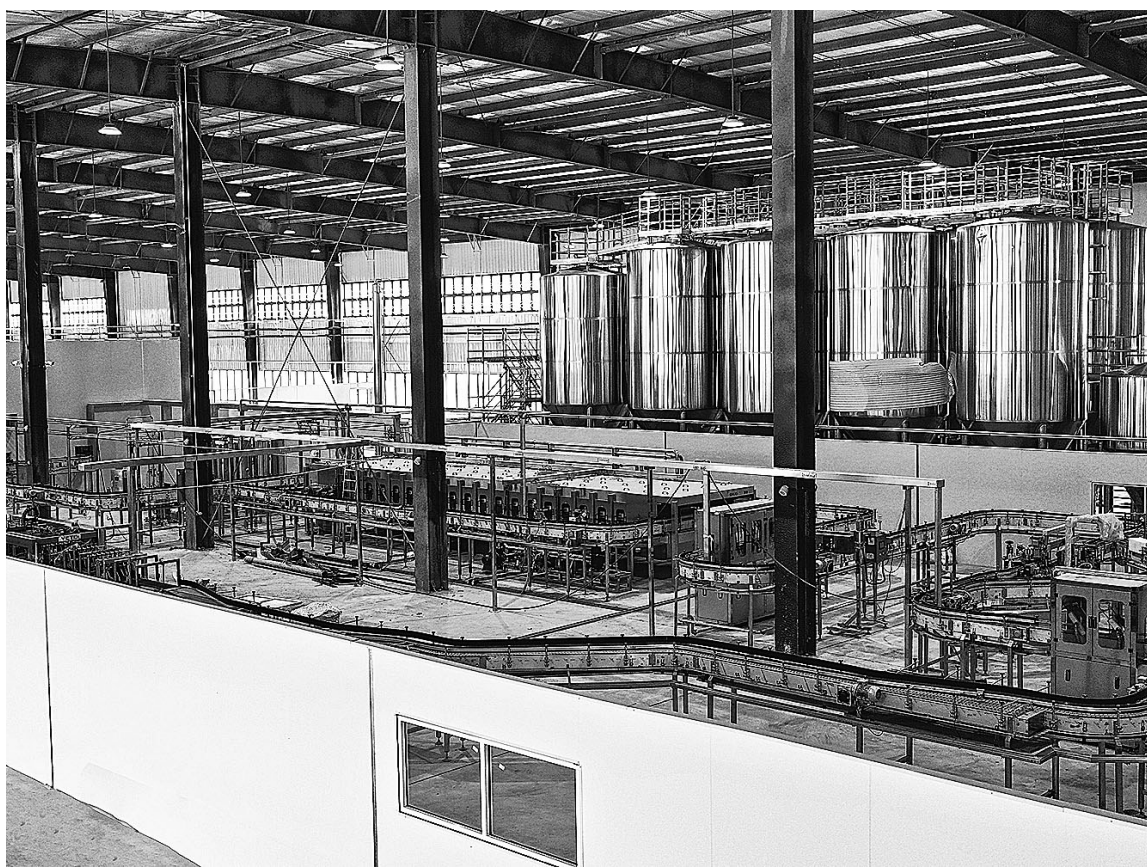
● 厂房内各类现代化设备安装完毕
