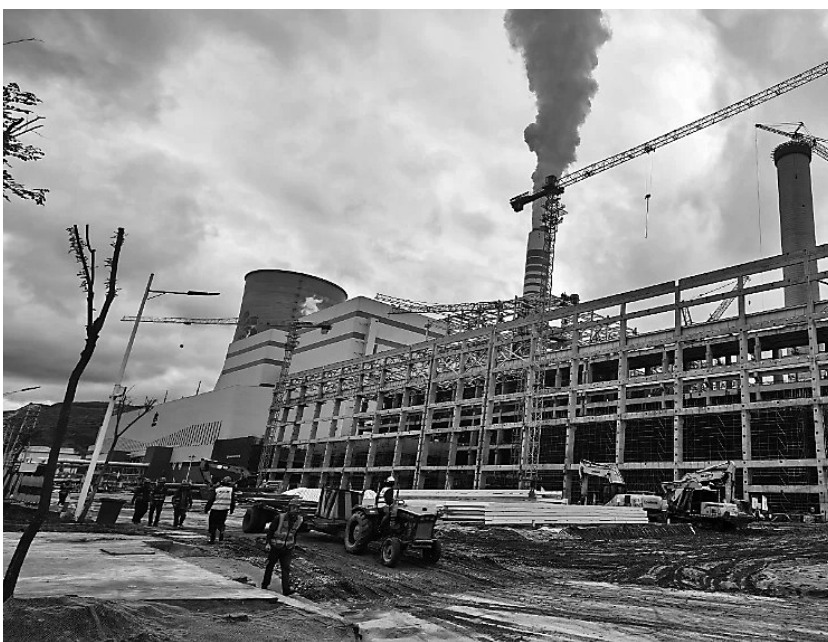
项目建设现场
