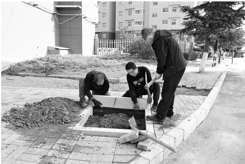
● 工人正在完善配套设施建设
