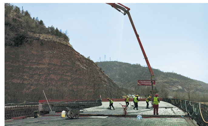
施工人员有序开展混凝土浇筑作业 记者 叶树峰 摄
