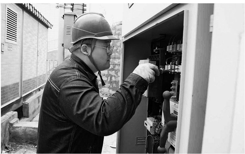
● 张裕正在城区进行线路巡查
