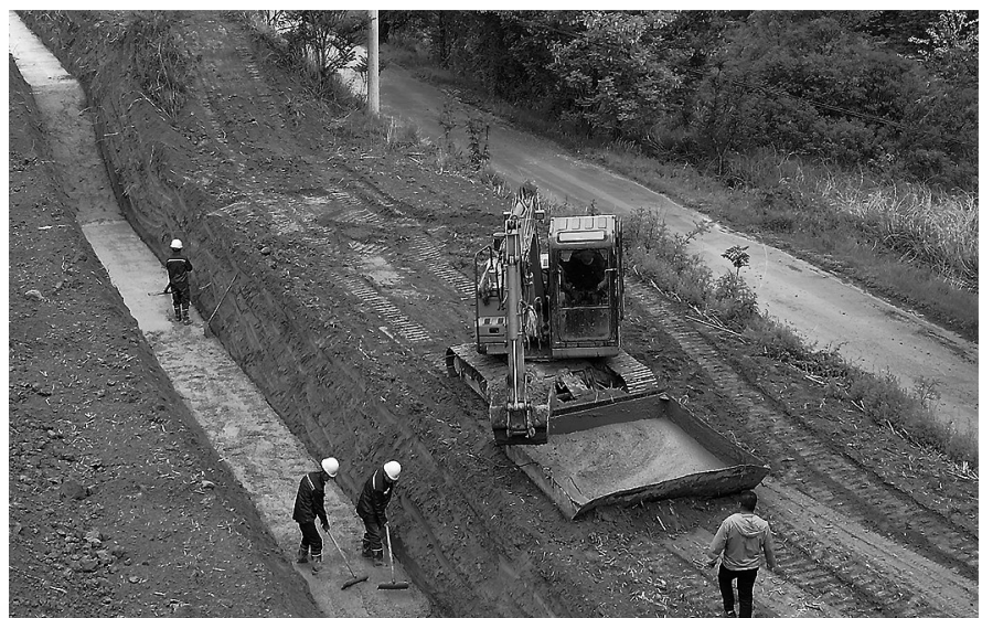
● 凤栖、交口河城乡供水一体化工程正在进行管沟垫层施工
