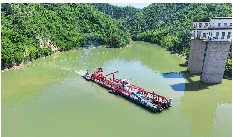
“东浚2号”在库区进行清淤作业
