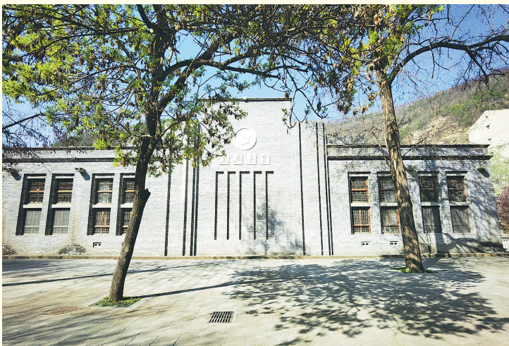
● 中共中央党校旧址礼堂修复后
