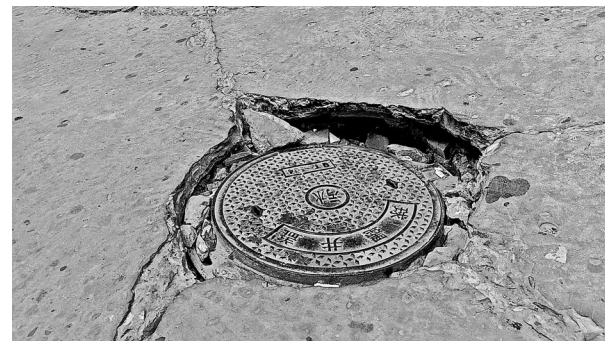
6月24日，市民李女士反映，中心街帝豪后方巷道的两处井盖已发生明显塌陷，对过往行人带来了安全隐患。
