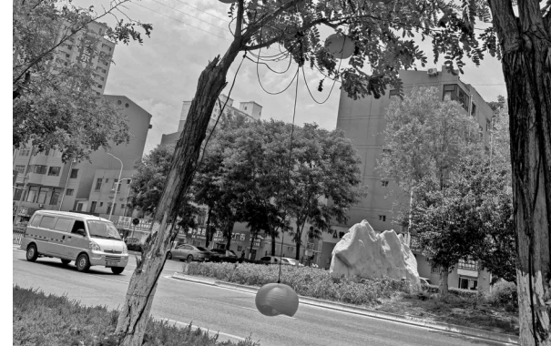
6月23日，市民刘先生反映，尹家路沿线的树木上，部分装饰灯笼已发生脱落，导致电线垂悬，对过往行人与车辆通行构成安全隐患。
